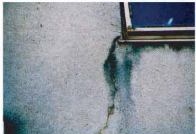
図-2 乾燥収縮によりひびのはいた建物外壁
