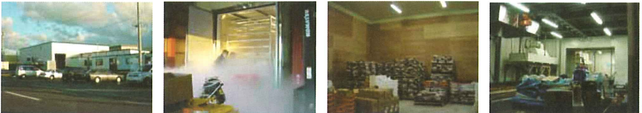
増毛町 常時-35℃という過酷な定温環境におかれる冷凍保管倉庫 設計シミュレーションによる提案から開始 高機能・低廉な注文戸建て住宅からはじまり、共同住宅、工場、倉庫、オフィスへと領域が進展
