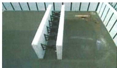
コンクリートを流し込む前の「断熱型枠」の施工事例
