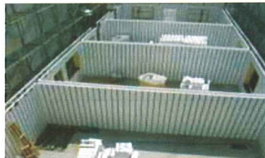
コンクリートを流し込む前の「断熱型枠」の施工事例
