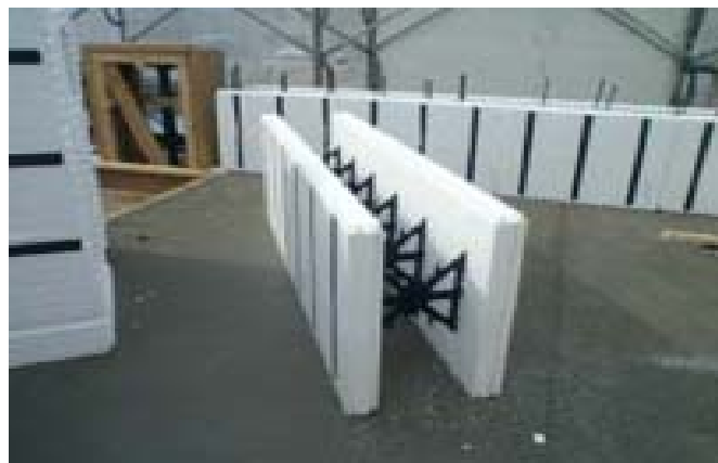
写真-1 コンクリートを流し込む前の「断熱型枠」
