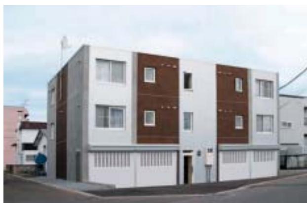
写真4 「断熱型枠」を用いたコンクリート構造物
