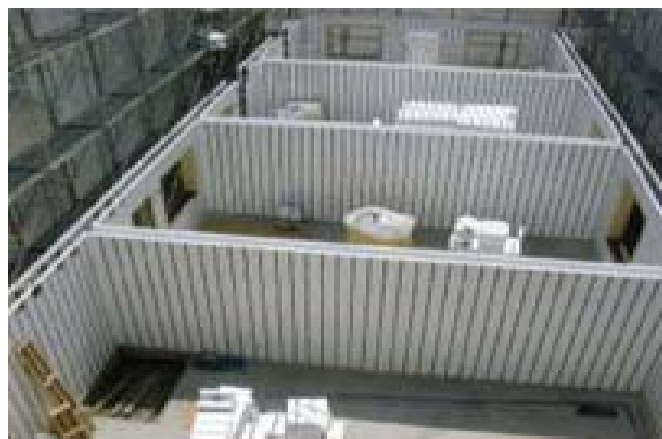
写真-2 「断熱型枠」の施工事例
