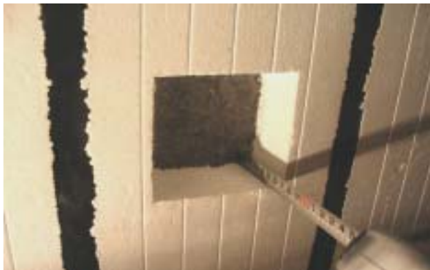
写真3 「断熱型枠」を用いたコンクリート
