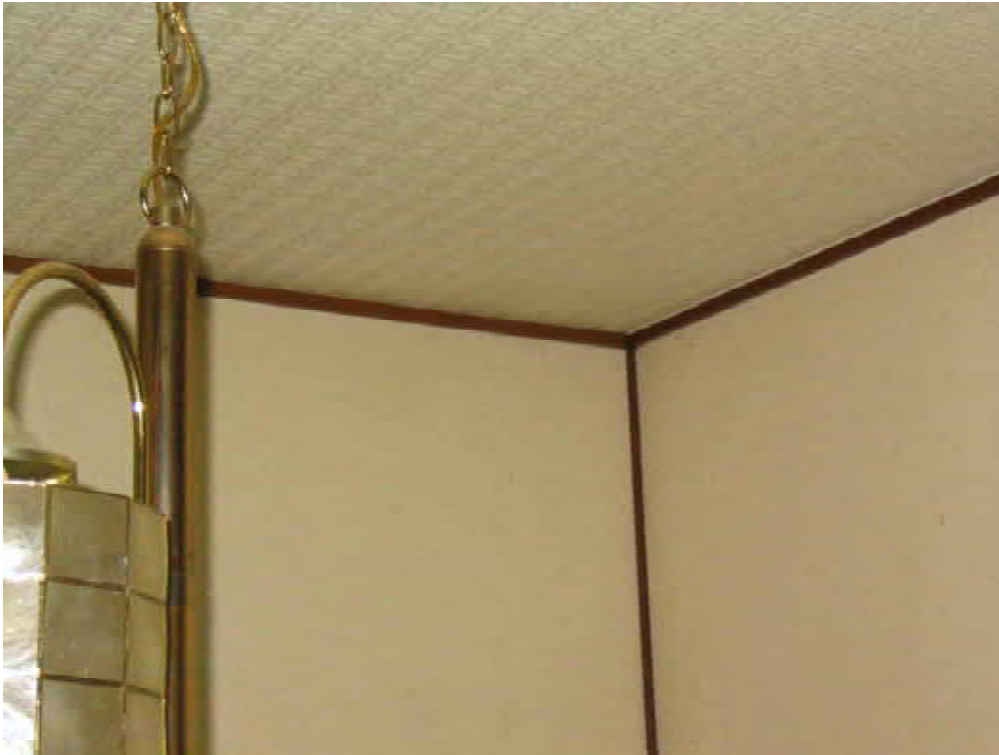
写真 6 - 2 2 階の天井の壁面（右側が南，左側が東）の接続の部分【T 邸】
