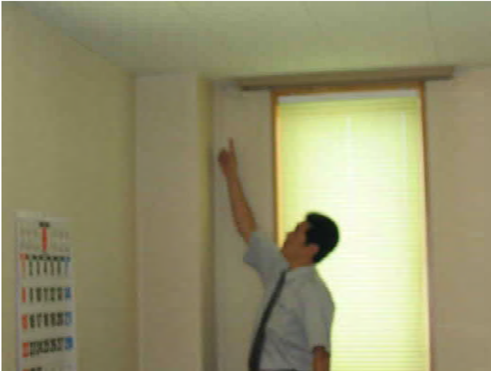
写真 8 - 5 2階の外壁が最も高い部屋の撮影【只石組社屋】
