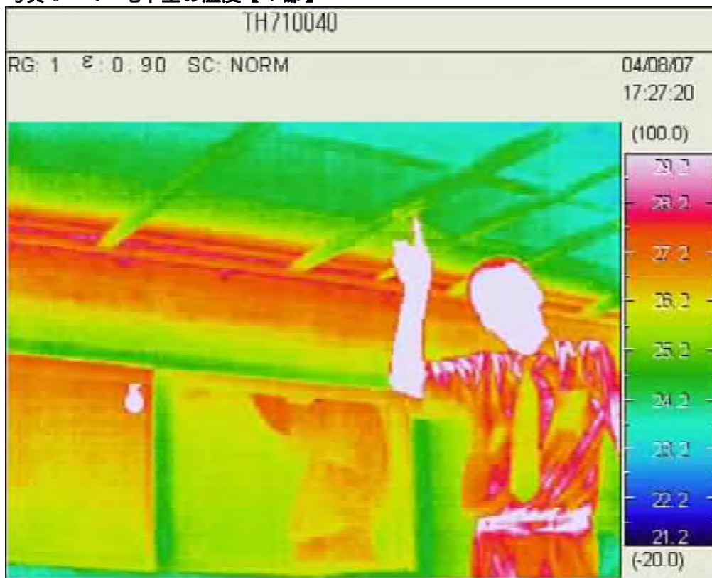
図 6 - 4 地下室の温度【T邸】
