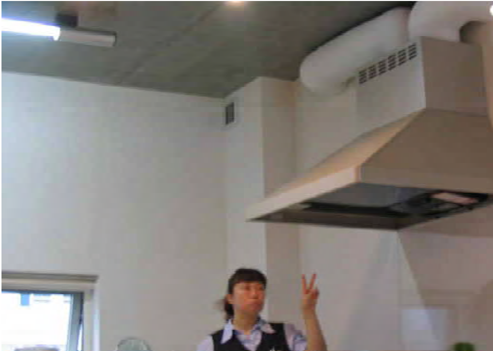
写真2-1 1階の天井面と南面（右）・東面（左）【ひじり野5邸】
