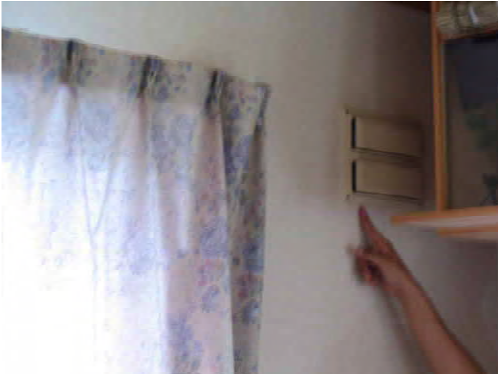
写真 4 - 3 1 階の南面の換気口【N邸】
