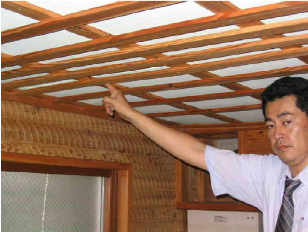
写真 6 - 5 地下室の天井面【T邸】
