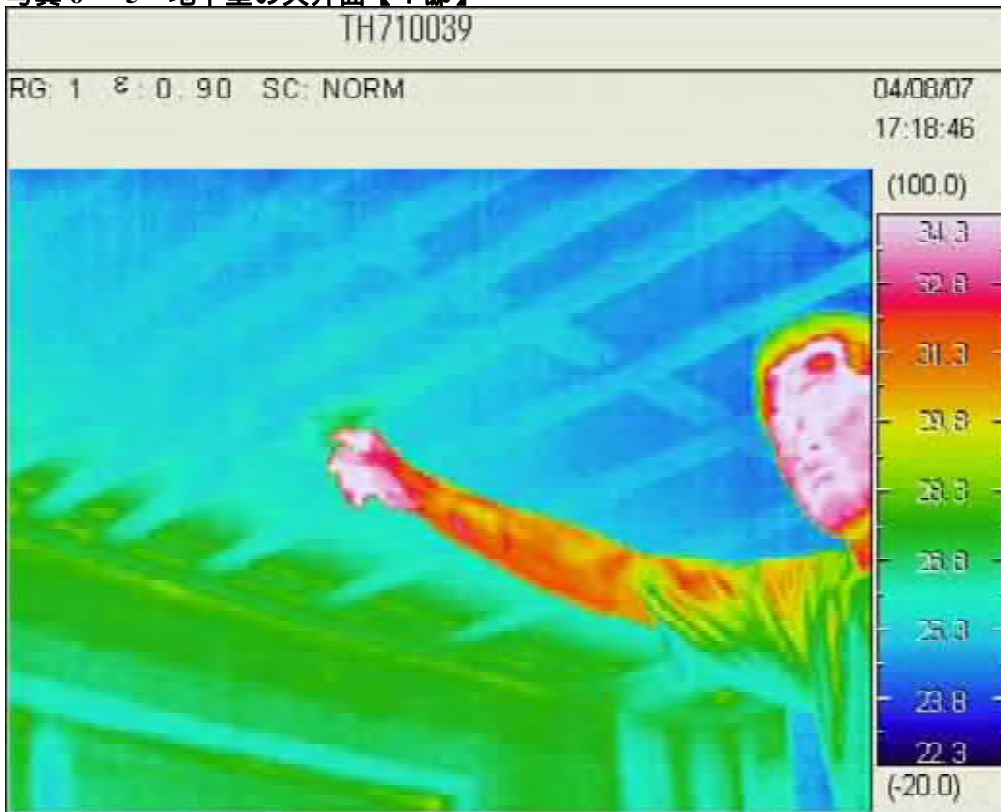
図 6 - 5 地下室の天井面【T邸】 地下室の天井面は 25 位。
