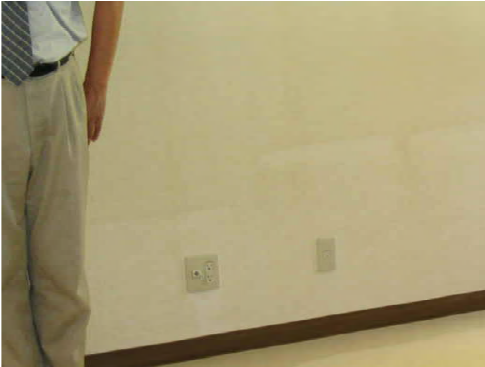
写真 8 - 6 2階の外壁が最も高い部屋の撮影【只石組社屋】
