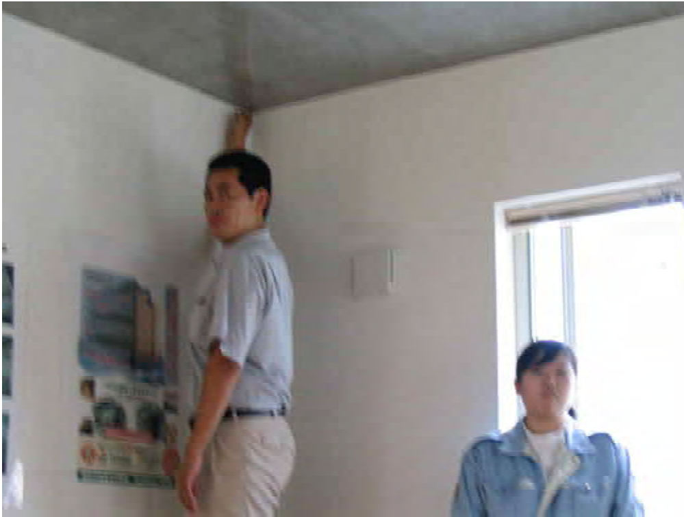
写真 2 - 3 2階の天井面・東面・北面【ひじり野5邸】
