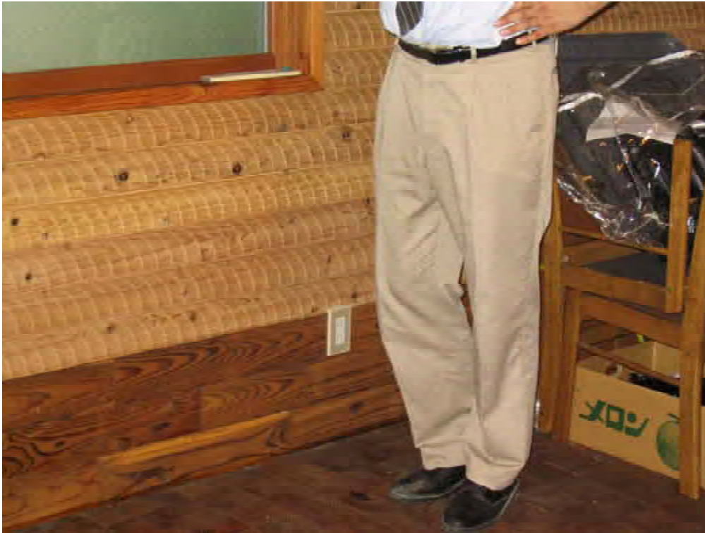
写真 6 - 6 地下室の下部【T邸】
