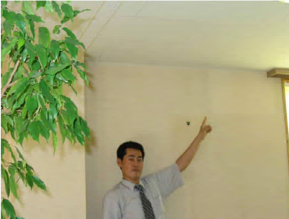
写真 8 - 4 2階の外壁が最も高い部屋の撮影【只石組社屋】
