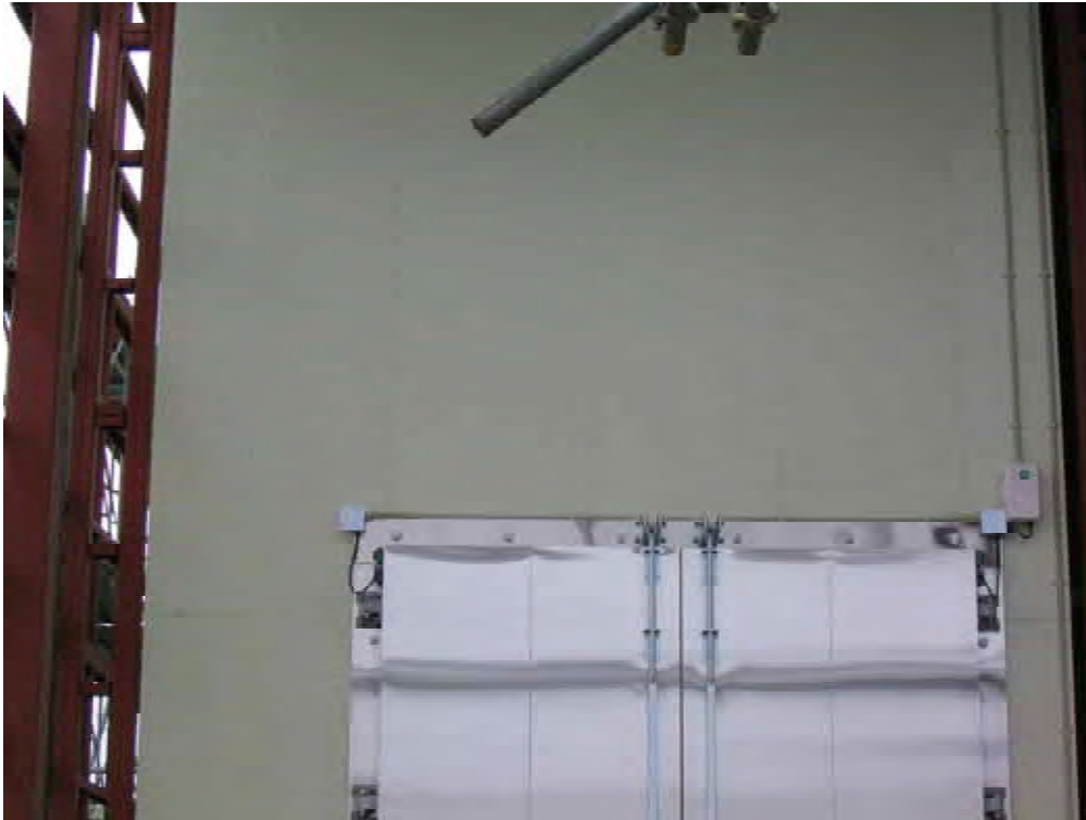
写真 3 - 1 冷凍冷蔵庫の外観【冷凍冷蔵庫】
