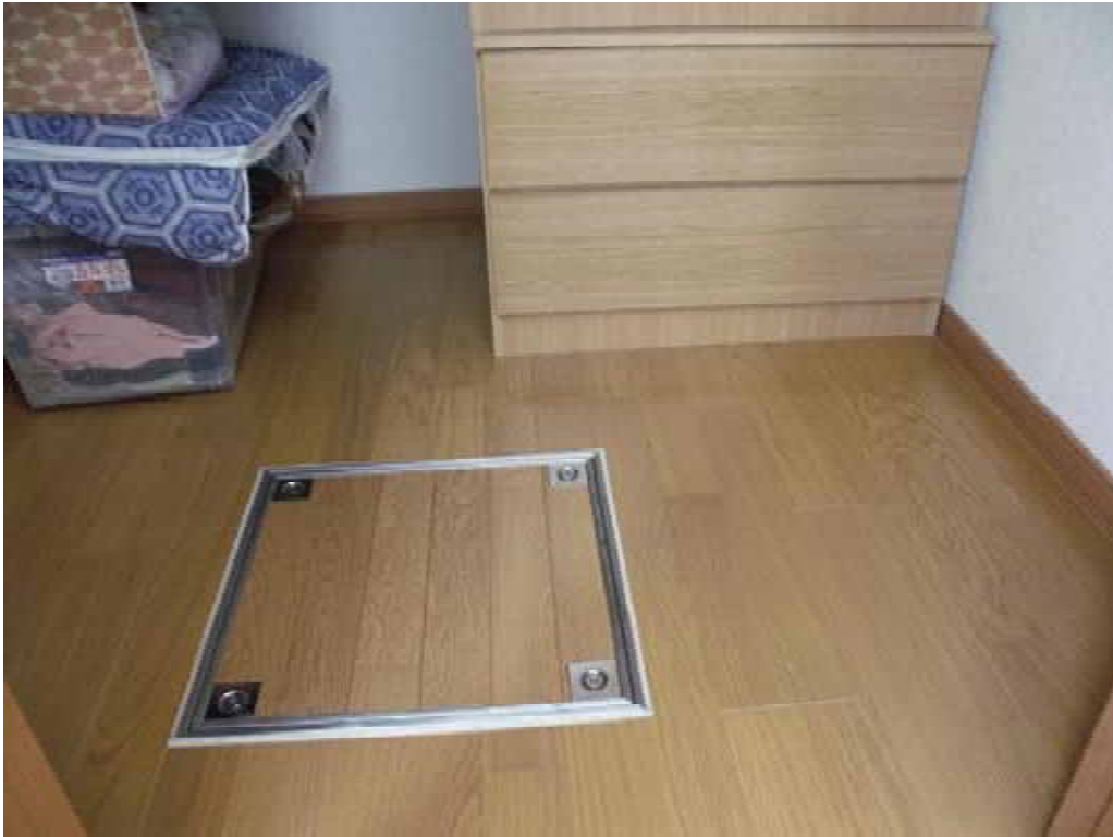
写真 1 - 6 1階の洋室のクローゼットの床面【A様宅】
