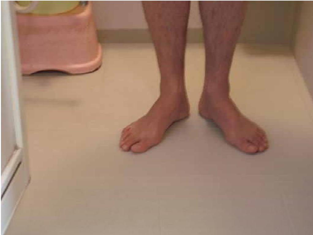
写真 4 - 2 1 階の浴室の床面と人の足【N 様宅】
