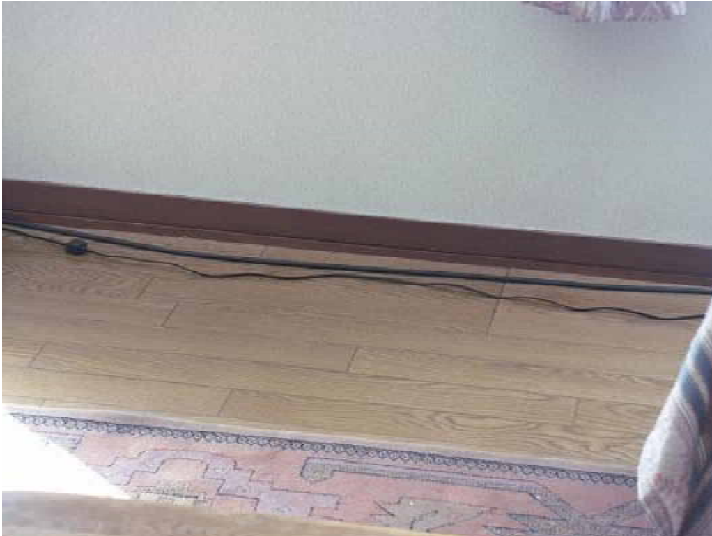
写真 3 - 4 1 階の居間の床面【Y、T 様宅】
