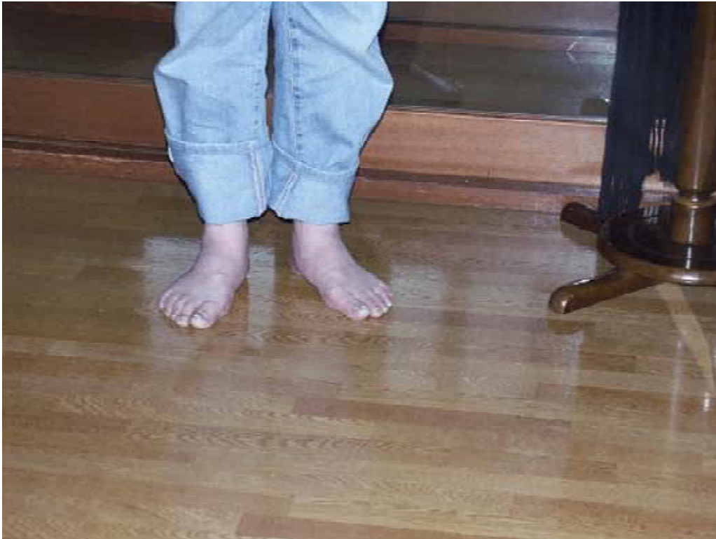
写真 3 - 3 1階の居間の床面と人の足【Y、T様宅】
