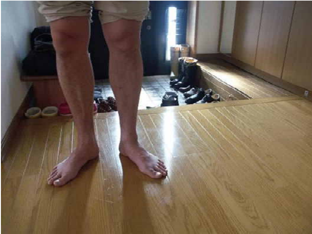
写真 2 - 5 1階のホールの床面と人の足【S様宅】
