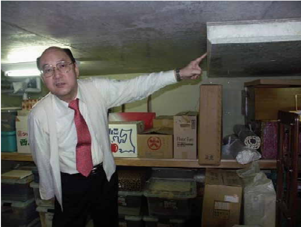
写真 1 - 11 地下1階の玄関の土間コンクリート【A様宅】
