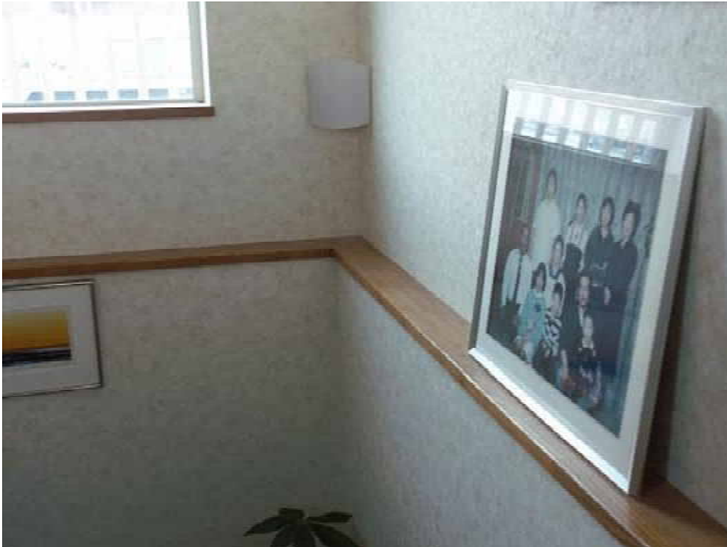
写真 6 - 3 2階の天井とペントハウスの境界面【N, T様宅】
