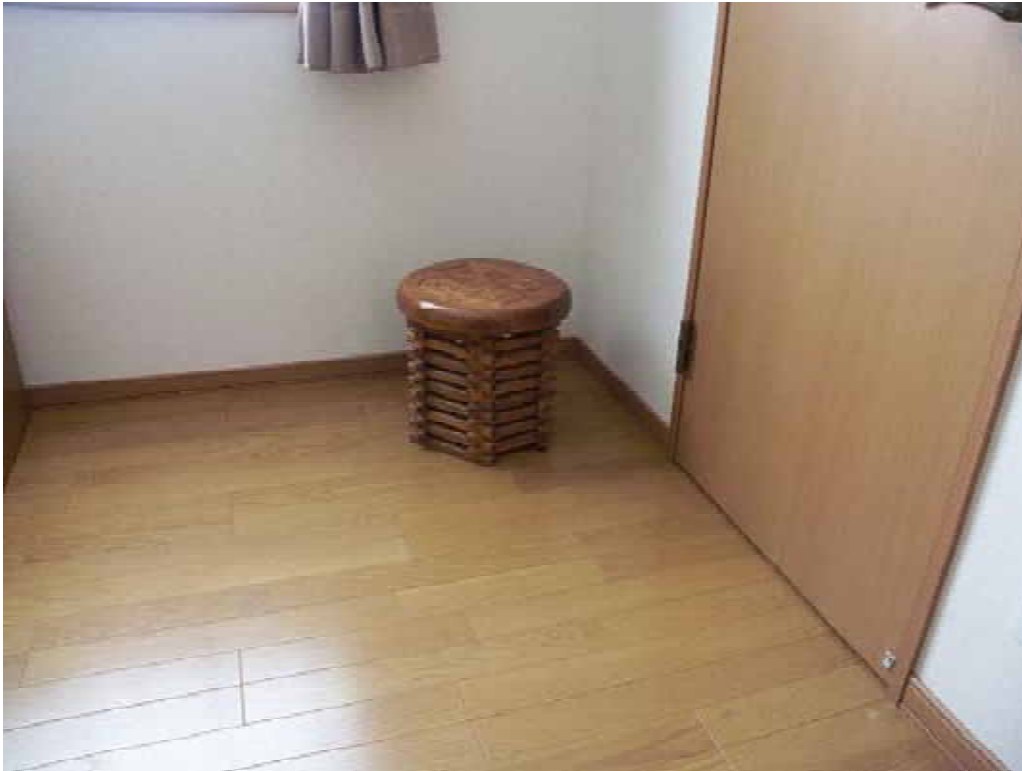
写真 1 - 8 1階の洋室（北側隅各部）の床面【A様宅】
