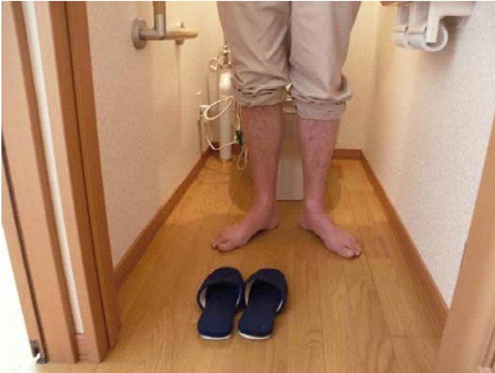
写真 1 - 2 1階のトイレの床面と人の足【A様宅】
