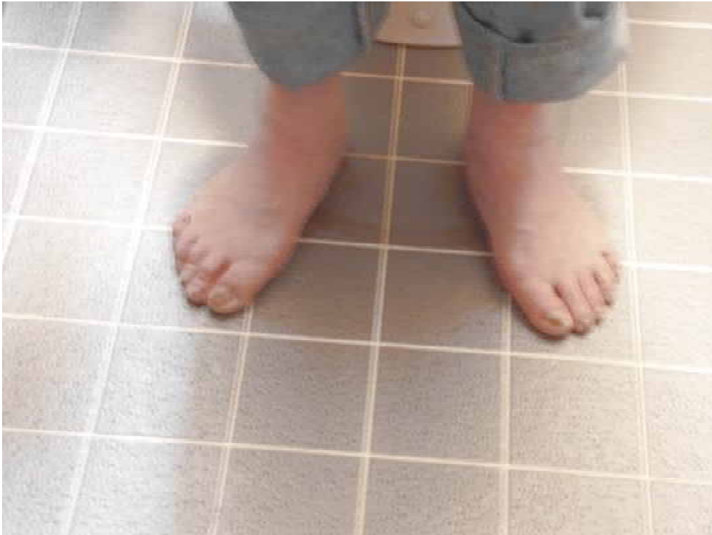
写真3 - 1 1階のトイレの床面と人の足【Y、T様宅】
