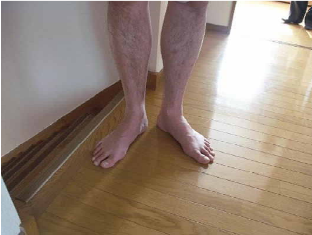
写真 2 - 7 2 階のホールの床面と人の足【S 様宅】
