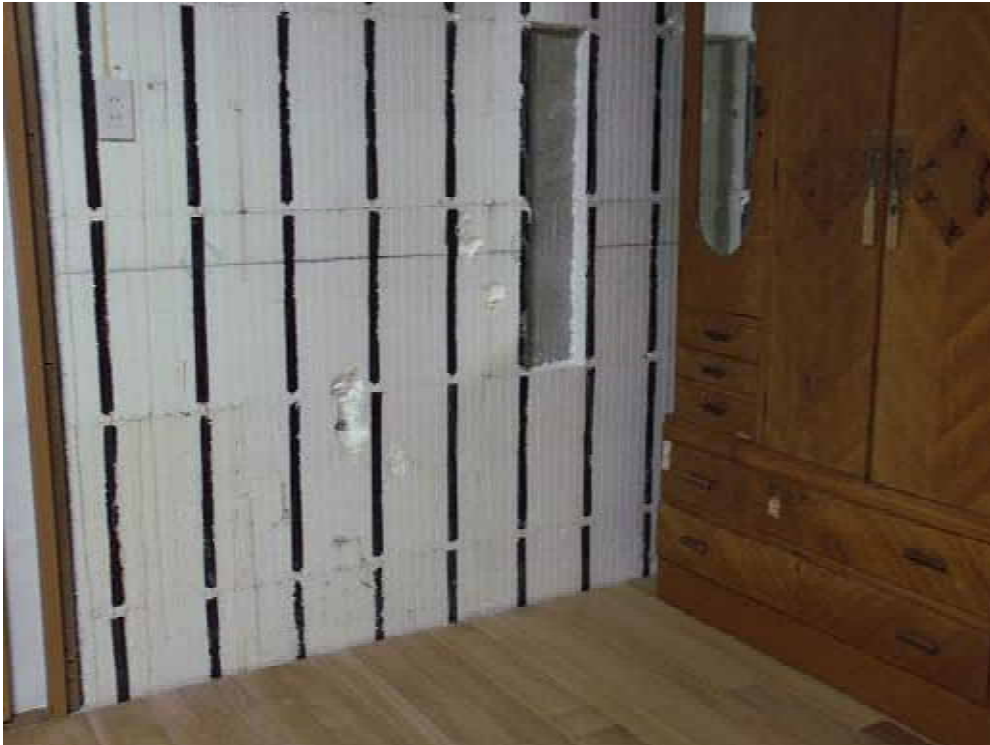
写真 6-1 地下1階の間仕切壁【N, T様宅】
