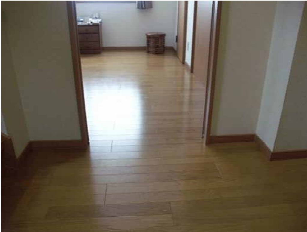
写真 1 - 5 1 階のホールと洋室の床面【A様宅】
