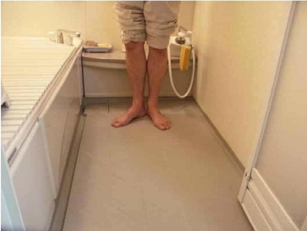
写真 1 - 3 2階の浴室の床面と人の足【A様宅】
