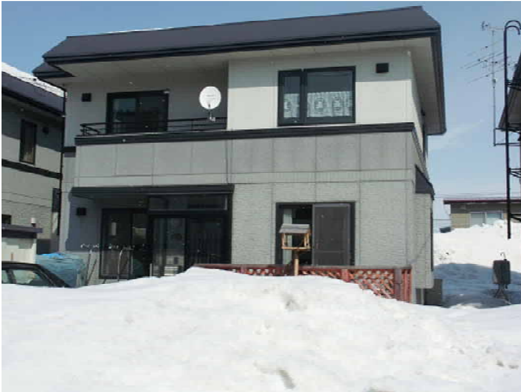
写真4 外観【N 様宅】
