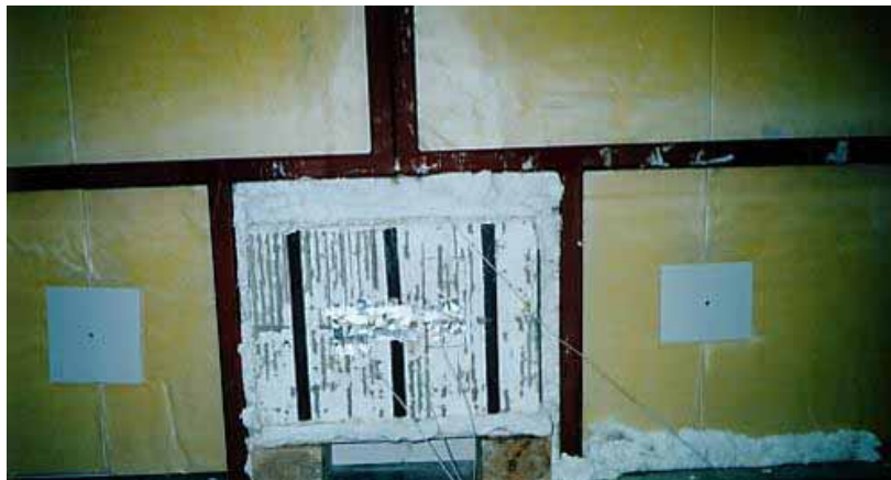
試験体加熱中 非加熱側の断熱材表面 (室内側内壁面) Max 29
